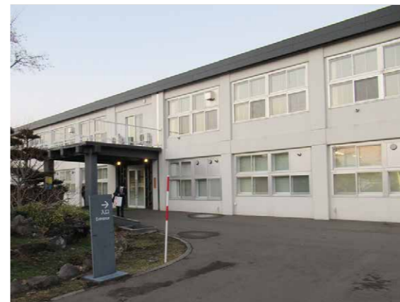
▲東川町立日本語学校の外観
