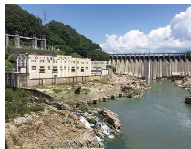
①大井発電所 外観(右奥に大井ダム)
