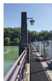
③大井発電所 堰上 柵など建設当時の 姿が残る
