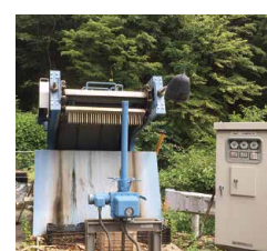
⑤加子母清流発電所 取水部 取水後は地中の水圧管を 通して発電所へ
