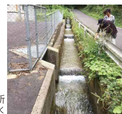
⑤加子母清流発電所 取水部 取水後は地中の水圧管を 通して発電所へ
