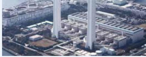
横浜火力発電所では、運転当初は燃料に重油・原油が使用されていたとのことですが、1984年以降はばい塵や硫黄酸化物を出さず、石炭、石油と比較して環境負荷の少ないLNGが使用されています。また、ACC(改良型コンバインドサイクル)と呼ばれる発電方式が採用され、燃焼によるガスタービンでの発電とともに、その排ガスから熱を回収して蒸気を発生させることで、蒸気タービンでの発電も行われています。これによりACCの7・8号機系列で熱効率(※)55.8%と、通常汽力発電での熱効率との比較で10%以上の効率向上を果たしているとのこと。
