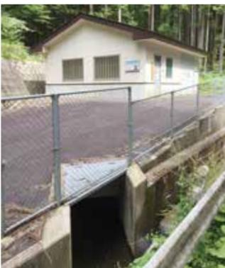
④加子母清流発電所 外観 写真下の放水路から発電後の水を農業用水に戻す
