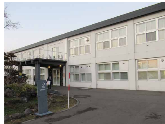
▲東川町立日本語学校の外観
