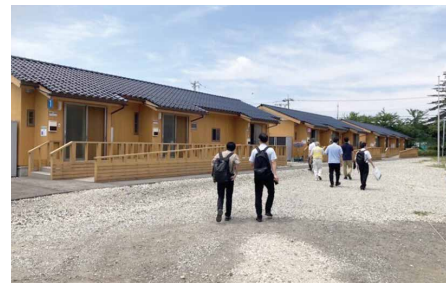
▲正院町第3団地 地域産の瓦屋根を用いた恒久仮設住宅であり、入居期限終了後は、公営住宅への移行予定
