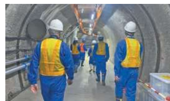
▲地下の坑道の様子
